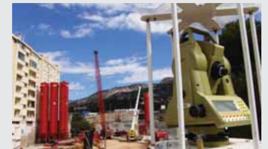
Тоннель скоростного движения Intercity Tunnel Тулон
